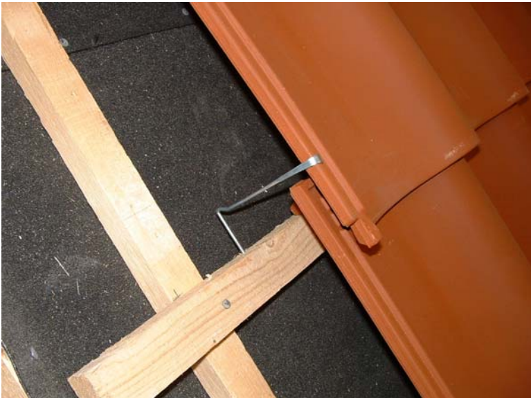
Kuva 4: Kattotiilien kiinnittäminen tiilikiinnikkeellä
