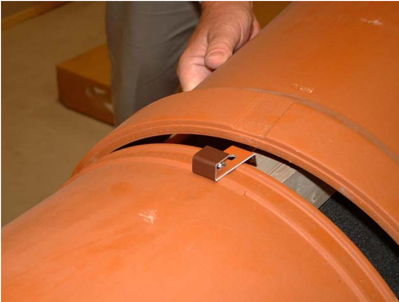
Kuva 5: Harjakiinnikkeen asennus
