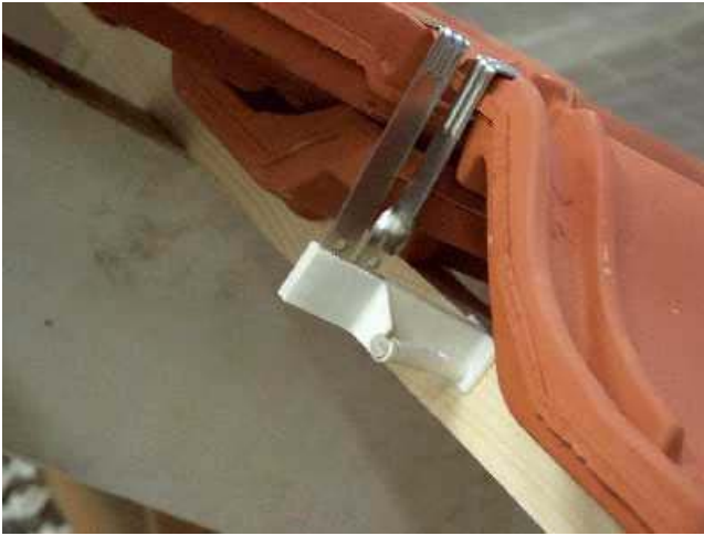
Kuva 5: Kattotiilien kiinnittäminen tiilikiinnikkeellä
